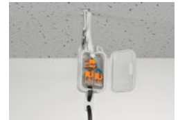
Anschluss von Pendelleuchten in abgehängten Decken
